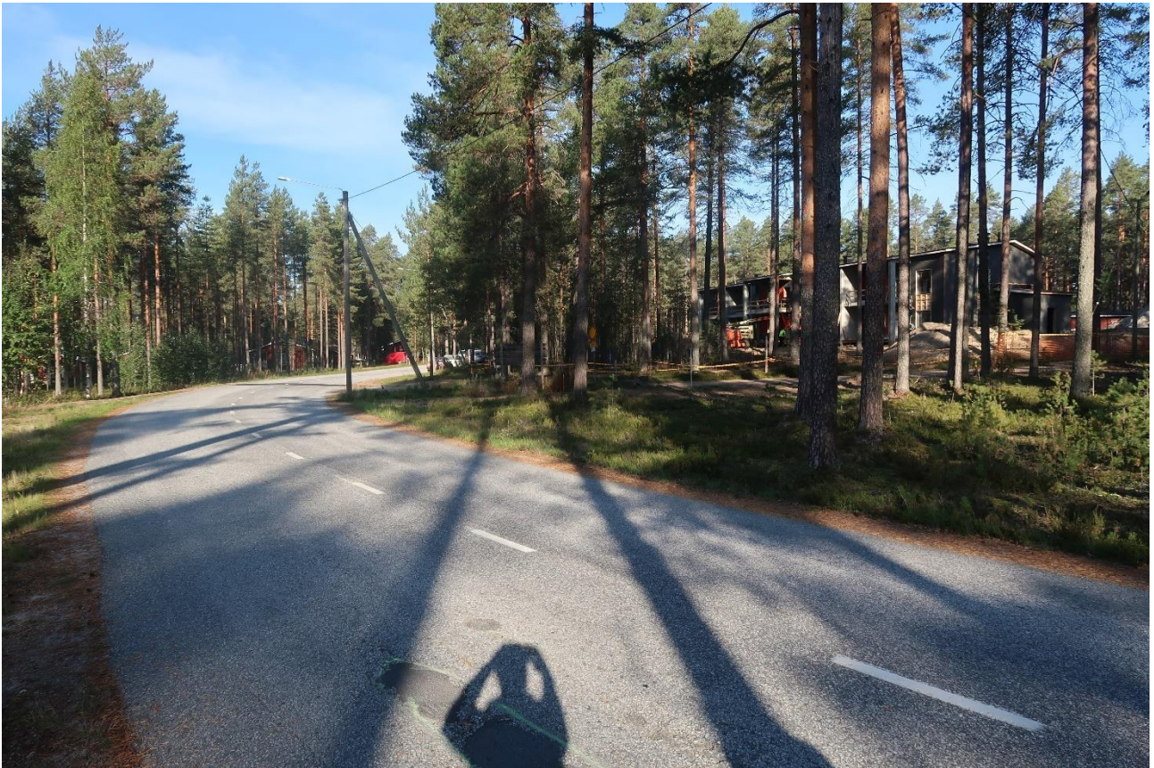
Kuva 4. Rakenteilla oleva luhtitalo korttelissa 419
