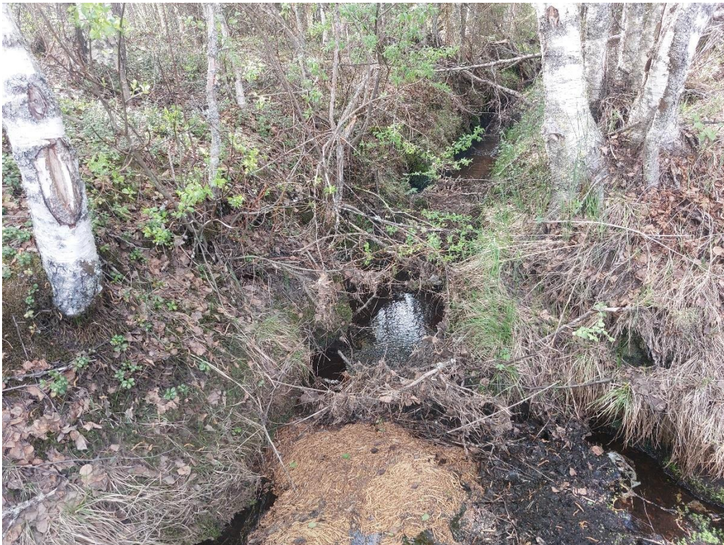
Kuva 28. Selkämänsuon pellon lounaisnurkalta johtava uoma alavirtaan kuvattuna 29.5.2024. Metsässä pellon jälkeen uoma kaventuu selvästi. Putkipadon voisi sijoittaa metsäosion alkupäähän heti pellon sarkaojan ja pääuoman risteyksen jälkeiseen kohtaan, joka kuvassa näkyy.
