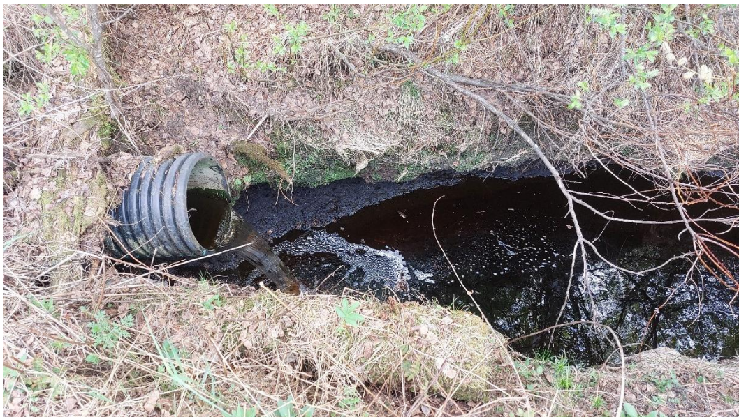
Kuva 26. Oja Selkämänsuon pellon lounaispuolella sekä pellolle johtavan tien allittava rumpu 29.5.2024.
