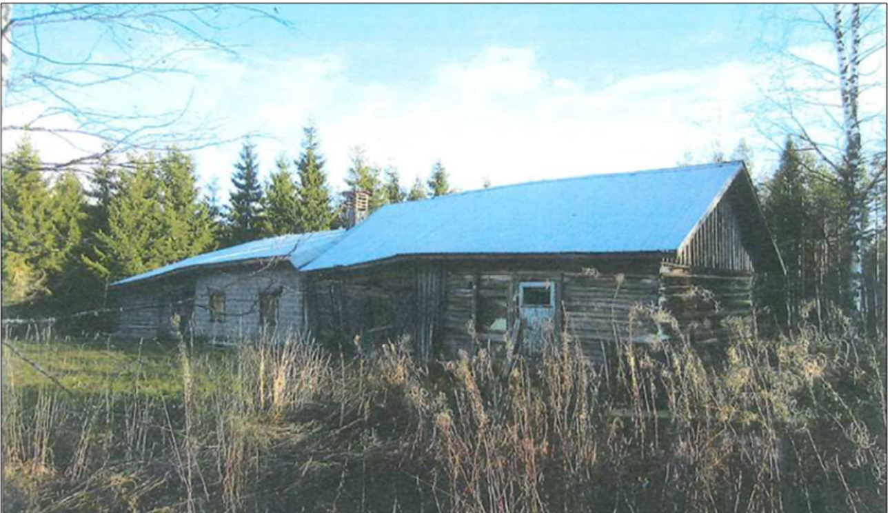
Kuva 21. Lanteen kiinteistöllä sijaitseva vanha karjarakennus (Elementis Minerals).
