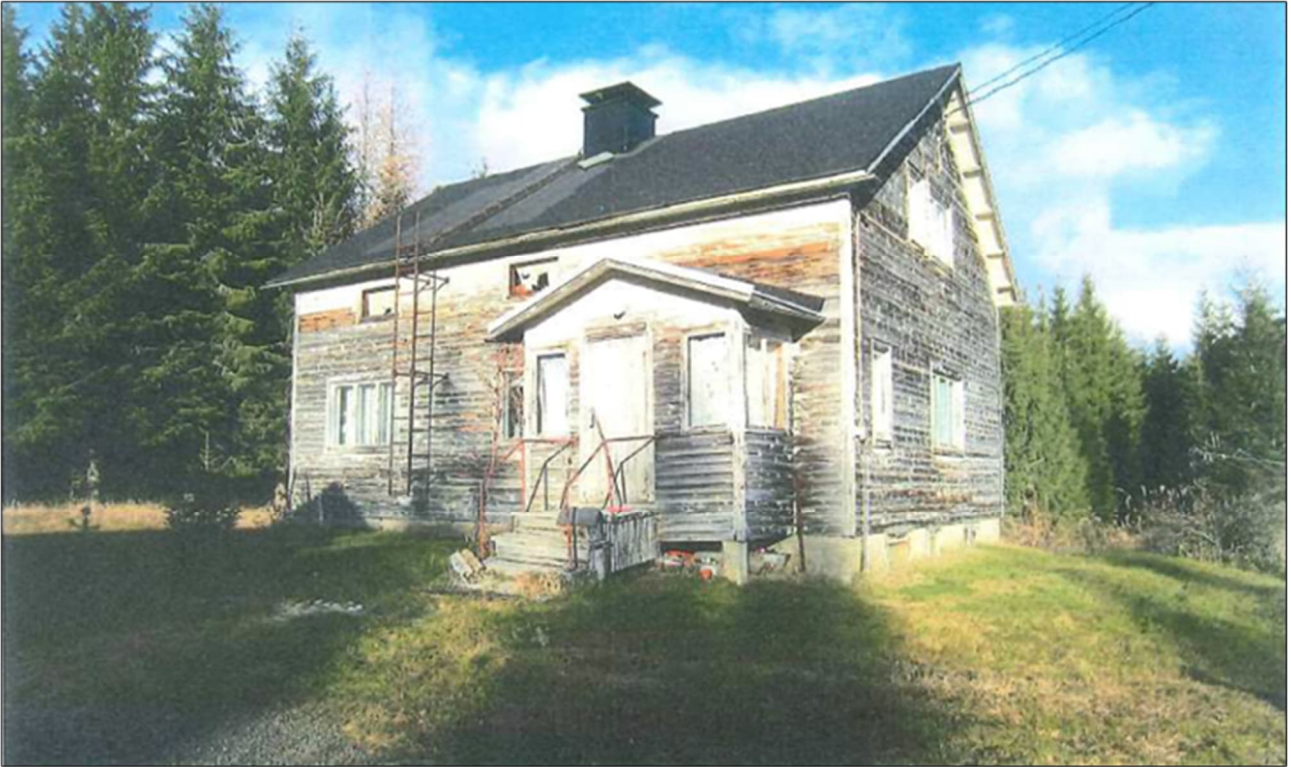
Kuva 20. Lanteen vanha asuinrakennus (Elementis Minerals).
